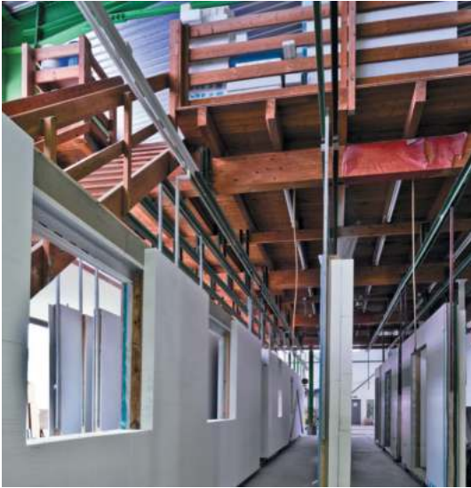
Короткий час будівництва завдяки готовим стіновим елементам
